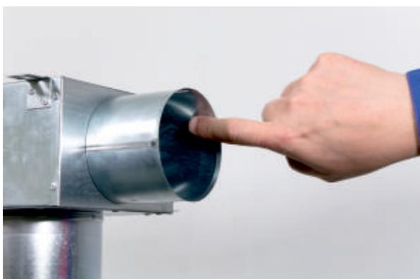
3) Lubrifier la surface interne de l'embout avec un produit de glissement\*.
